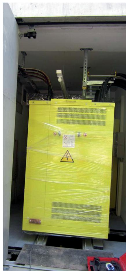
Ersatznetztransformator in der CEP: Hier wird der Strom von 6 kV auf 400 Volt umgewandelt.
